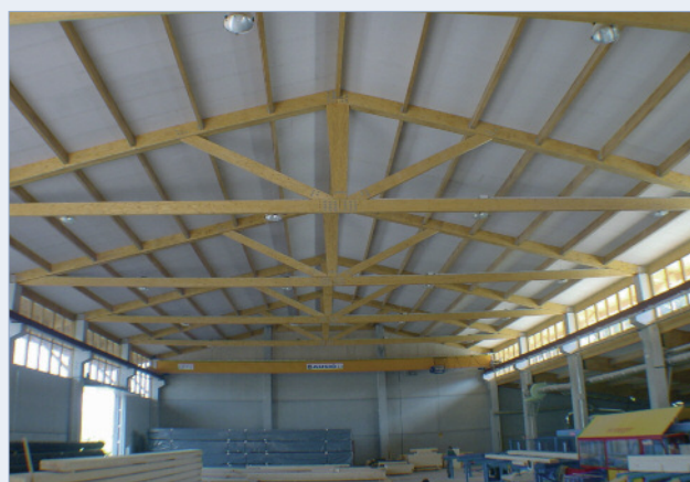
Exemple d'une ferme treillis
