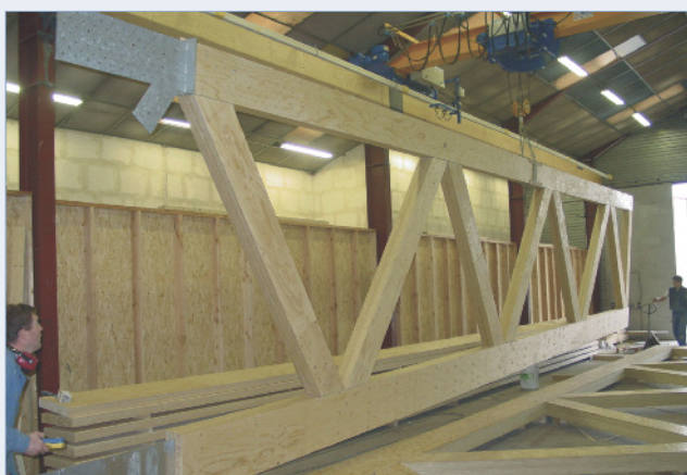
Fabrication d'une demi-ferme treillis
