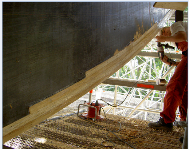
Type 2 : Réparation d'une section existante dégradée
