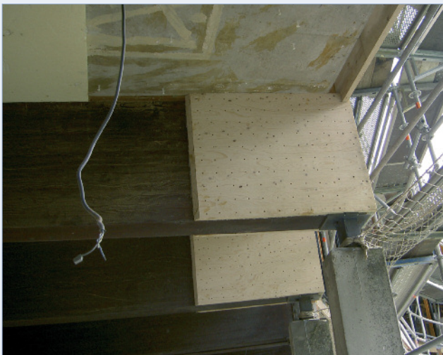
Type 3 : Renfort d'appui
