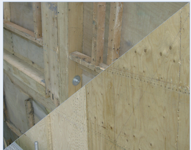
Type 4 : Renfort de contreventement (montant + voile)
